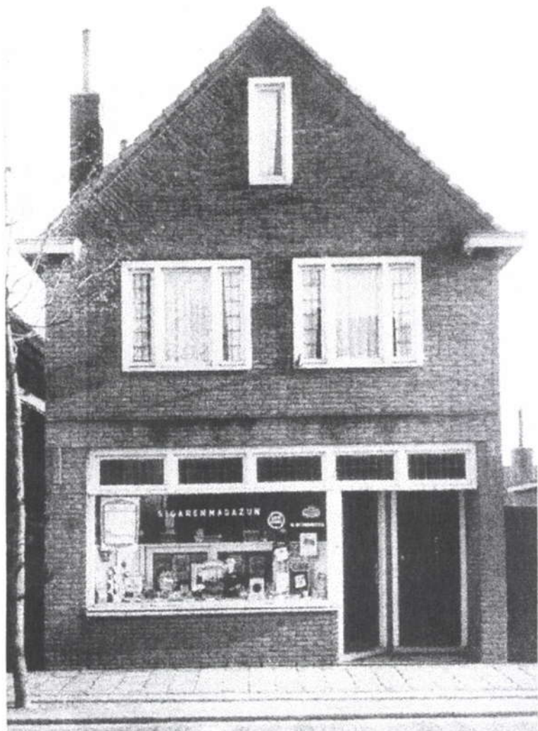
Woonhuis met winkel aan de van Hoogendorpstraat (nu Dorpsstraat). Achter het huis de sigarenfabriek. Kosten van de totale bouw: f 5000,- (1932)
